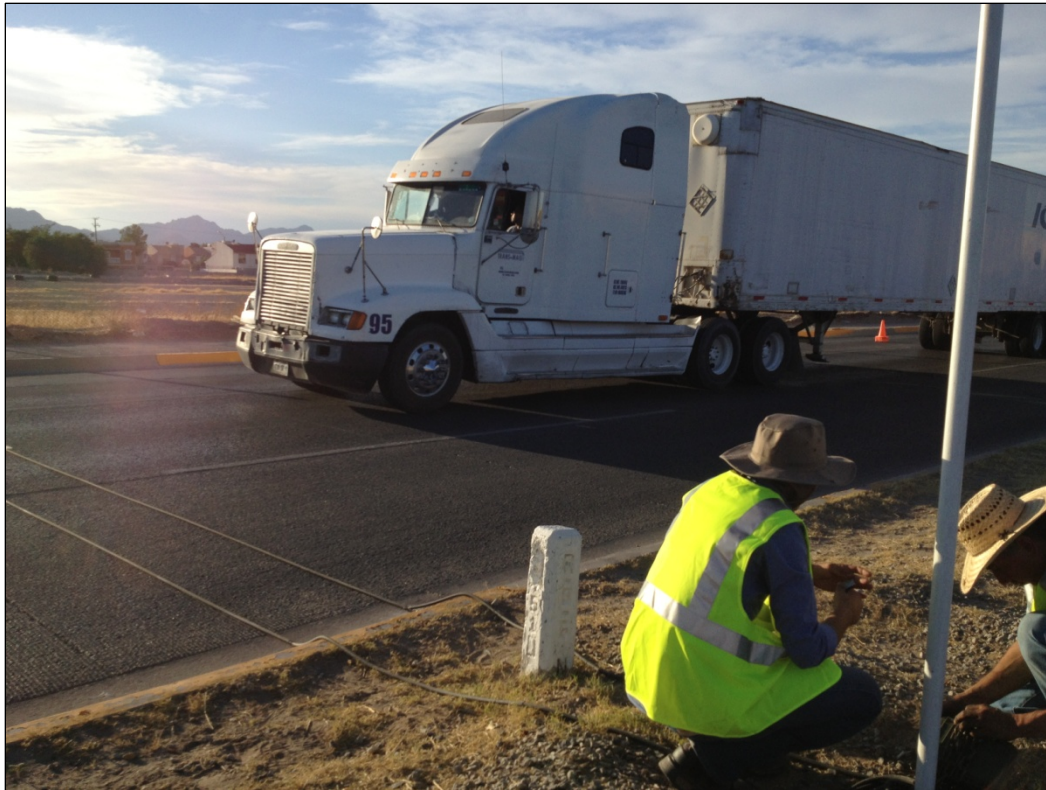
Ilustración 16. Instalación de Contador Neumático
